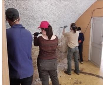
Le fait de retrouver la pierre sous les enduits étanches a révélé l'inertie des murs. Avec un poêle d'atelier, l'atmosphère a complètement changé. L'humidité a disparu et les murs conservent maintenant la chaleur.
